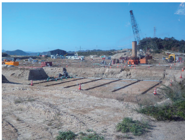
写真11 地下水浄化のための揚水と掘削作業 (2020年11月、筆者撮影)
