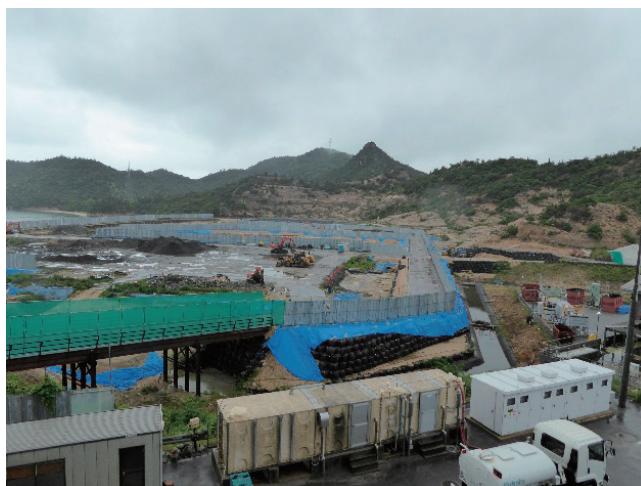
写真7 処理完了を目指し、仮橋や廃棄物施設ヤードを設置した産業廃棄物不法投棄地 (2016年6月、筆者撮影)
