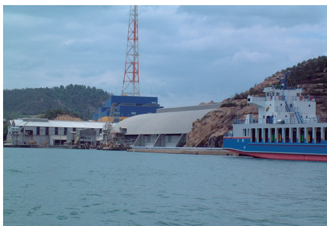
写真3 直島の中間処理施設と専用フェリー（太陽）（2003年6月、筆者撮影）
