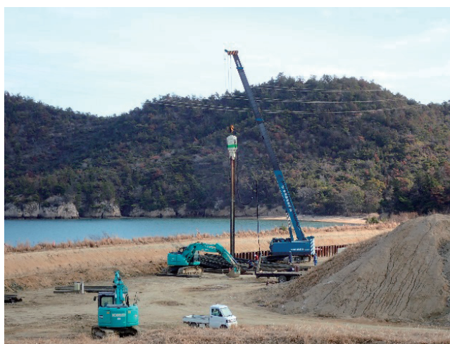
写真12 遮水壁鋼矢板の引き抜き作業 (2022年2月、筆者撮影)
