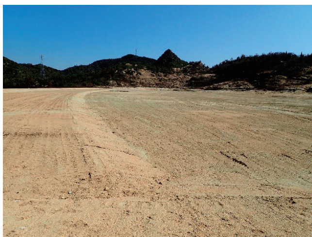
写真13 整地が完了した豊島産業廃棄物不法投棄地跡地（2023年3月、筆者撮影）
