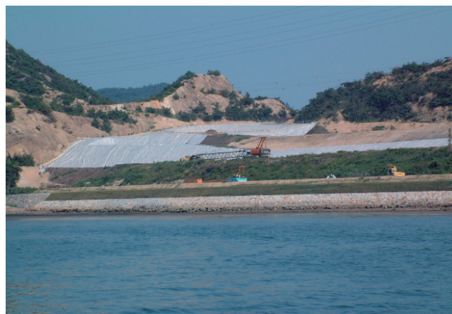
写真2 豊島での環境保全工事（2001年7月、筆者撮影）
