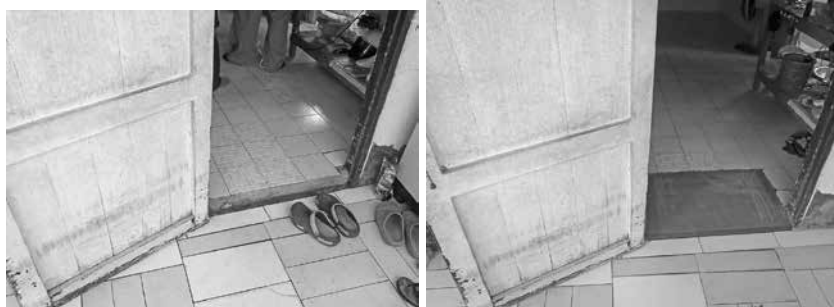
写真9 玄関の段差解消のようす (Before→After)
