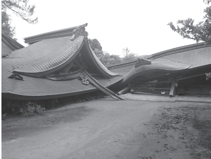
写真2 熊本地震によって倒壊した阿蘇神社
