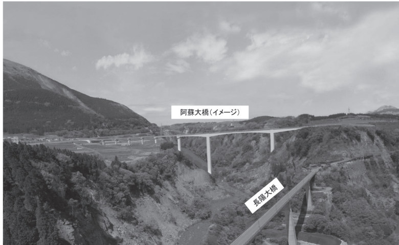
写真17 阿蘇大橋の橋梁形式：P C 3 径間連続ラーメン箱桁橋 (略称：P C ラーメン橋)
