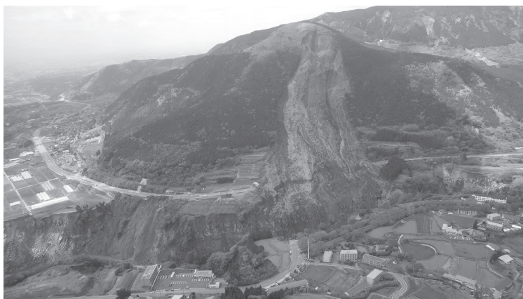
写真6 南阿蘇立野地区の大規模な山腹崩壊と阿蘇大橋の落橋
