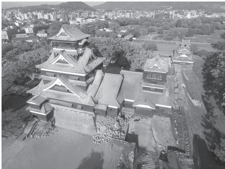
写真1 熊本地震によって損傷した熊本城天守閣
