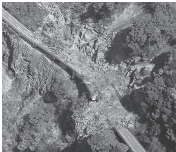
写真 16 斜面崩落による戸下大橋の上部2径間落橋
