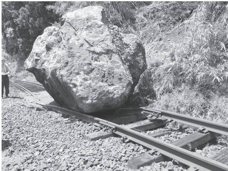
写真11 豊肥本線立野―赤水間の線路をふさぐ落石
