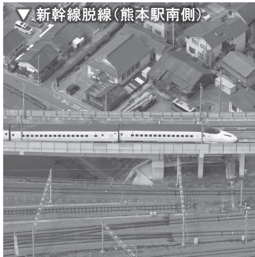
写真10 熊本地震による九州新幹線の脱線
