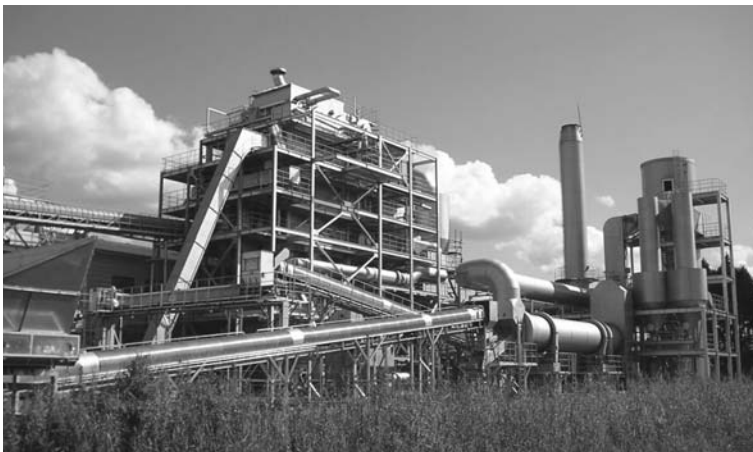
写真10 能代バイオマス発電所のボイラ,乾燥機,排ガス処理施設
